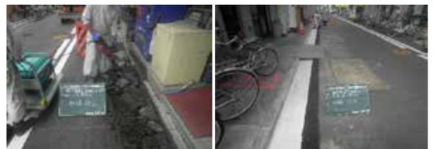
舗装の補修をする前に、雨水等の排水施設である既存のコンクリート施設を壊し、新設します。
