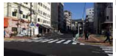
施工写真(A-1)
