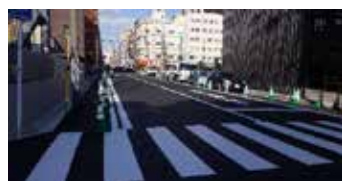
施工写真(C-4)
