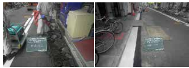
L形側溝工
