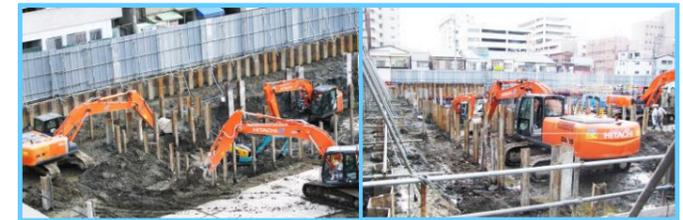
山留工事・H鋼切断・斜染掛け
